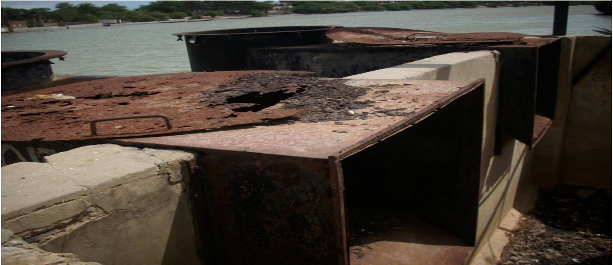
Photo 1 : Ouvrage de Bango
