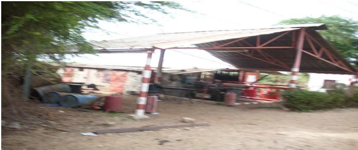
Photo 9: Station de pompage de la SOCAS à Bango
