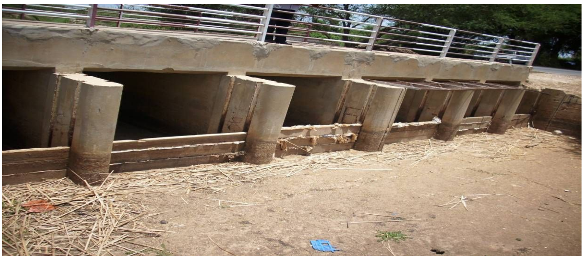
Photo 2 : Ouvrage de Ndiawdoune
