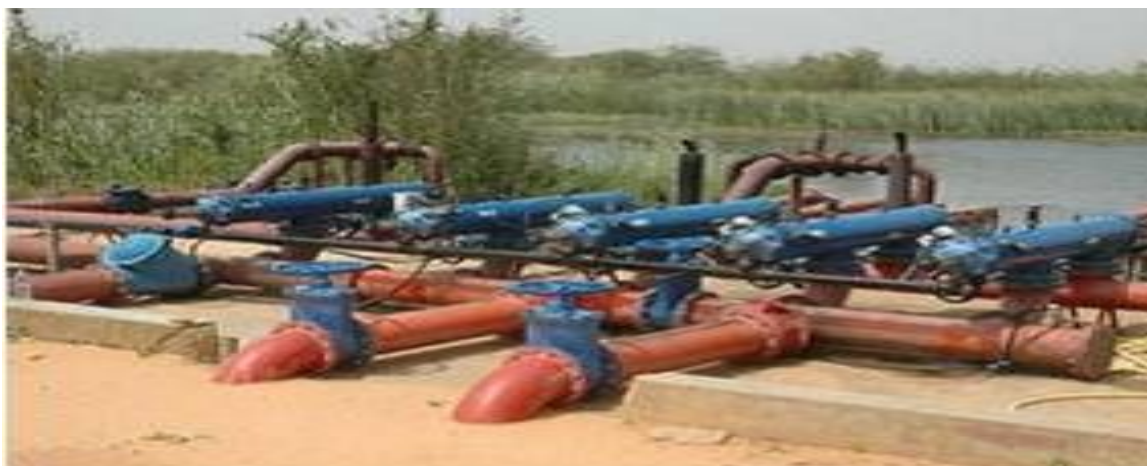
Photo 10: Pompage des GDS dans la réserve (Cliché : Eddy Graëff et D.R Radio France Internationale (RFI)) dans Kamara, 2008.
