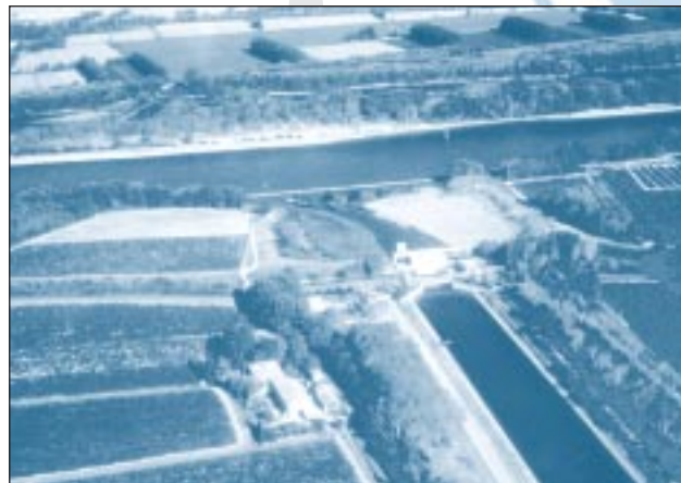
Le canal d'irrigation "Philippe Lamour" dans le Languedoc (France) - Photo BRL
